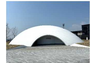
サステナドーム外観
