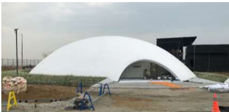
図 I-7 CO 2 吸収型建材を利用したサステナドーム
