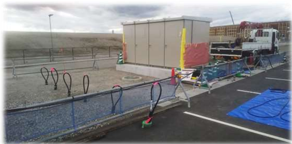
アスファルト前分電盤設置位置、キュービクル
