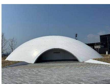
図 3-6 CO<sub>2</sub> 吸収型建材を利用した建築物（サステナドーム）
