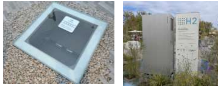
図 3-2-7 水素供給パイプラインと供給先の水素燃料電池
