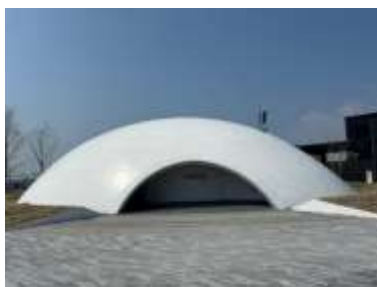
図 3-2-17 CO 2 吸収型建材を利用した建築物(サステナドーム)
