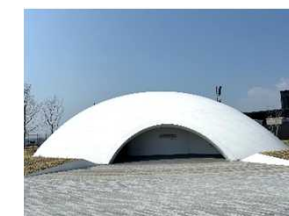
サステナドーム外観
