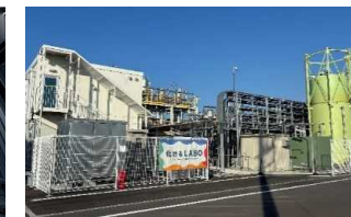
化けるLABO外観 (メタネーション)
