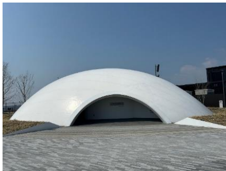
図 3-2-17 CO 2 吸収型建材を利用した建築物（サステナドーム）
