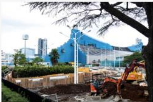
国立代代木競技場建設現場
