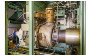
【アンモニアガスタービン】
