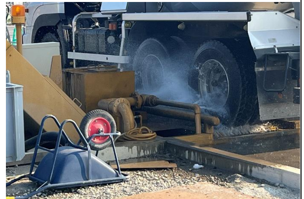
写真4 タイヤ洗浄の様子
