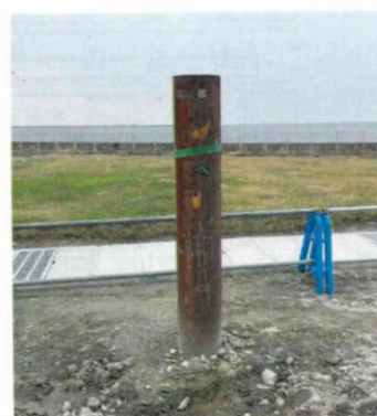
「図5:既存ガス抜き管 外観写真」
