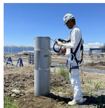
[図7:ガス抜き管周辺の測定状況(再掲)]
