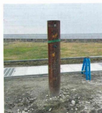
〔図5:既存ガス抜き管 外観写真 〕
