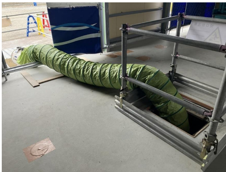
[図 17: 作業中の地下ピットの機械換気]
