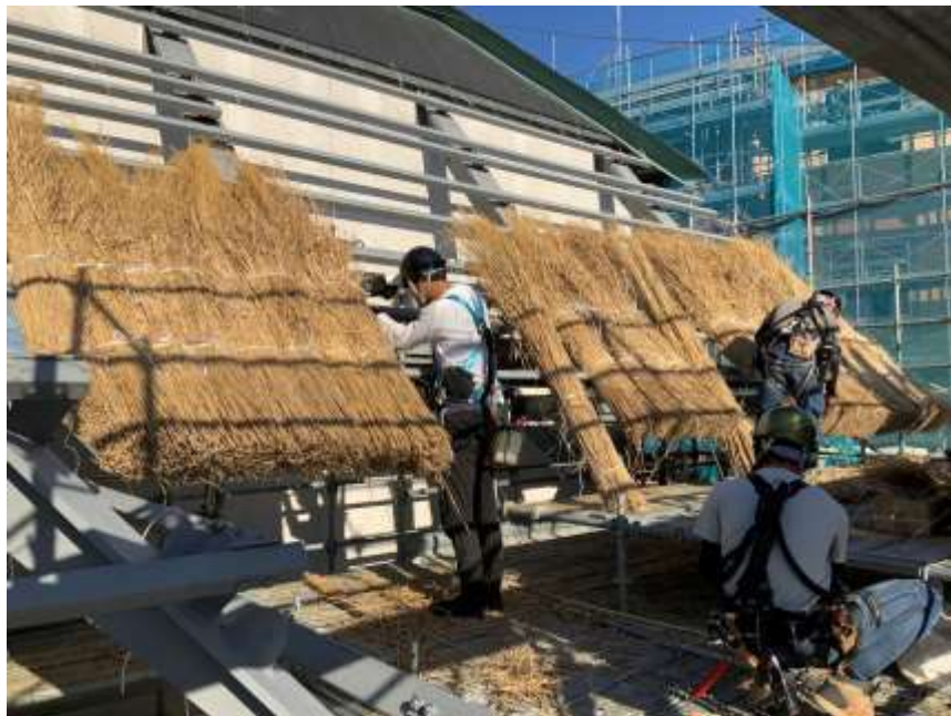
鉄骨下地への茅材の取り付け
