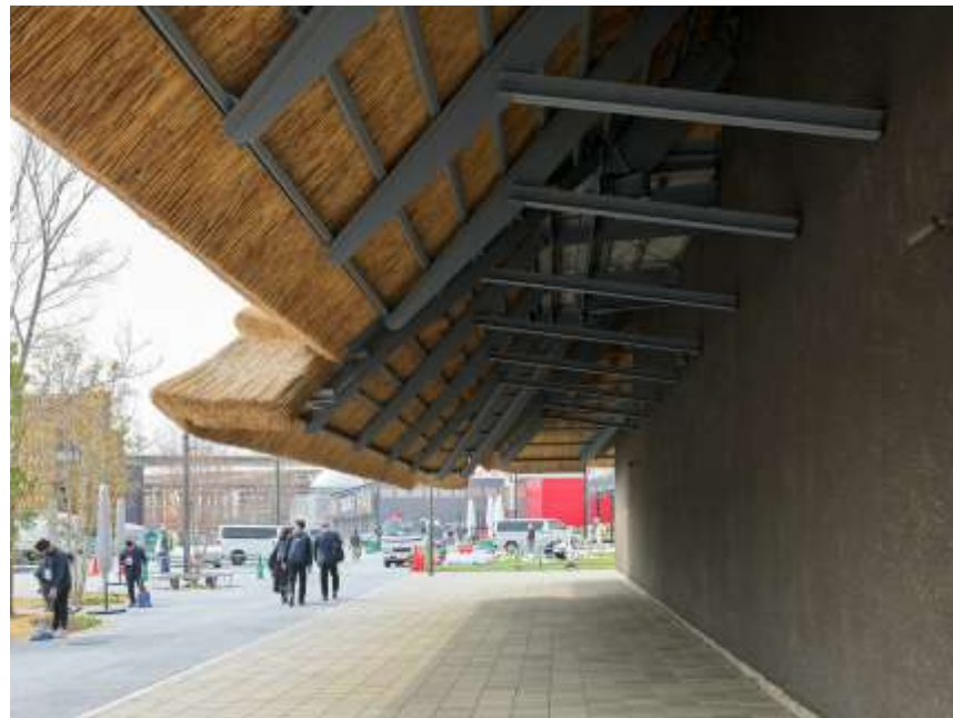
鉄骨造ならではの深い軒下空間
