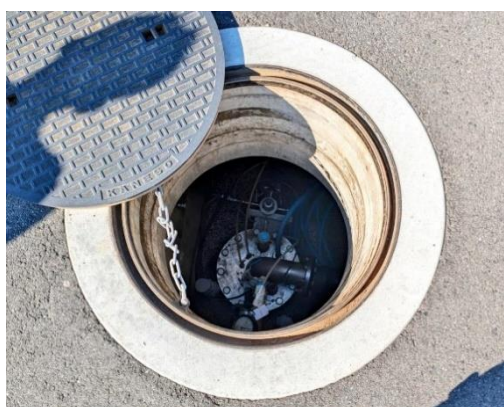
図 11 会場内に実装された帯水層蓄熱システムの熱源井
