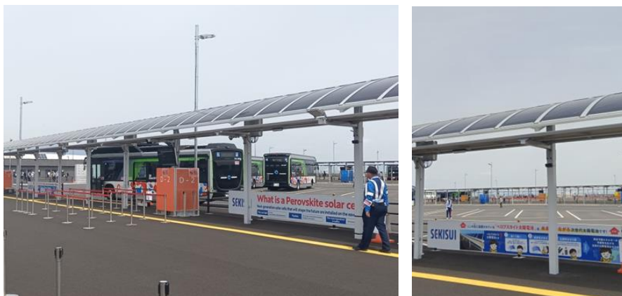
図 9 夢洲第1交通ターミナルに設置されたペロブスカイト太陽電池付バスシェルター
