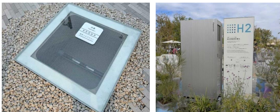
図 7 水素供給パイプラインと供給先の水素燃料電池
