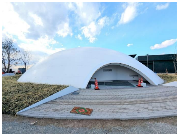
図 17 CO 2 吸収型建材を利用した建築物(サステナドーム)
