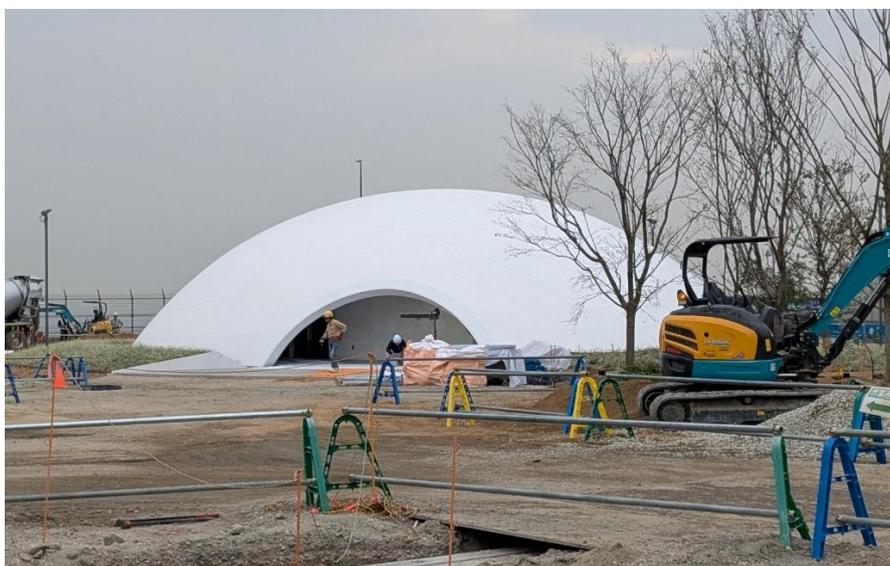
図 I-7 CO<sub>2</sub>吸収型建材を利用したサステナドーム
