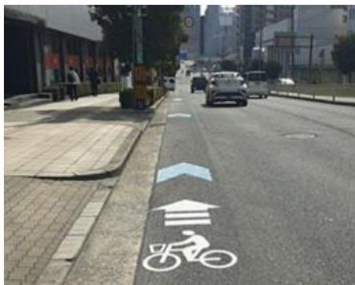
一般道における矢羽根型（標準形）路面表示 河川空間を活用した自転車歩行者専用道路 ※写真出典：国土交通省HP（太平洋岸自転車道）
