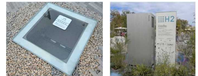
水素供給パイプラインと供給先の水素燃料電池
