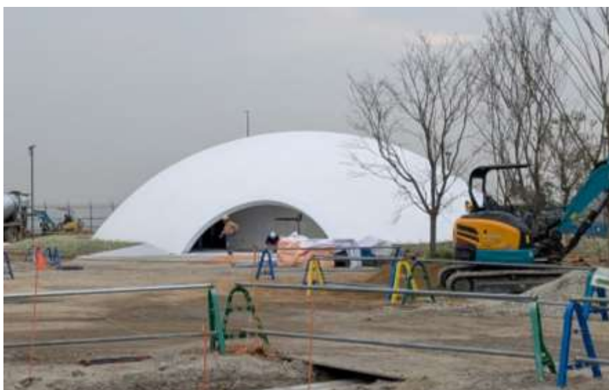
図 3-6 CO 2 吸収型建材を利用した建築物(サステナドーム)
