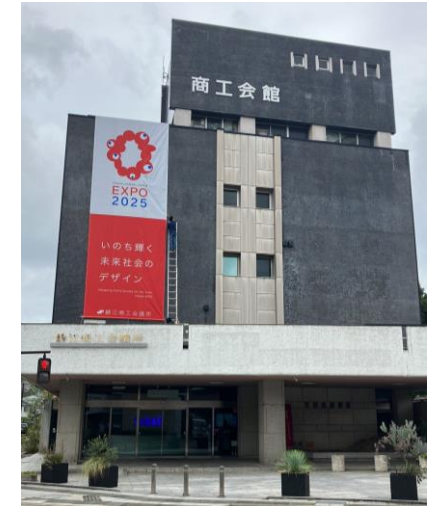
鯖江商工会館壁面への 巨大バナー設置
